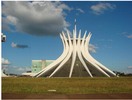
Catedral de Brasília Disponível em: < http://static.panoramio.com/photos/original/4505806.jpg >. Acesso em 25/11/2009.
